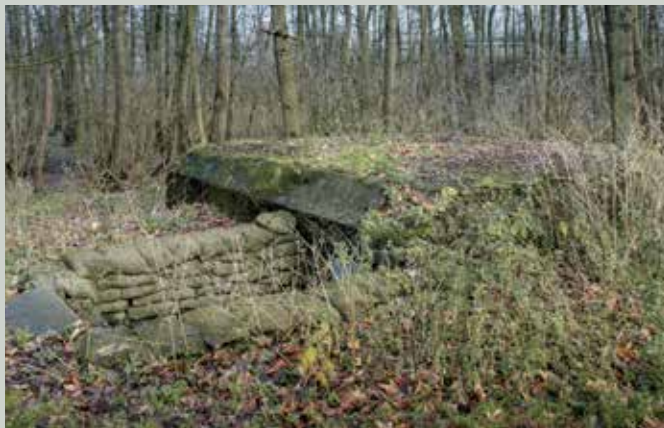
Gereconstruceerde ingang van afwachtingsbunker nr. 93 aan de 'gesprongen brug' in Turnhout, herbestemd als vleermuisbunker. (© Erfgoed Noorderkempen)
