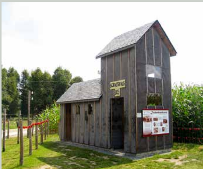
Reconstructie schakelhuis K5 in Zondereigen (© Amalia Van Solms)
