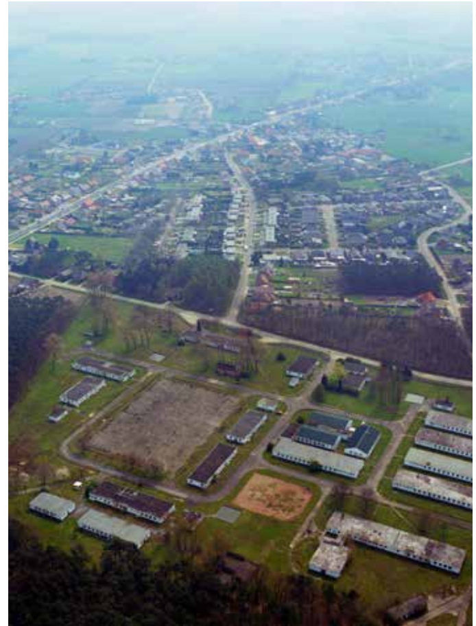
Luchtfoto van Kamp C in 2001 met de militaire gebouwen (© Kamp C provinciaal centrum voor duurzaam bouwen)
